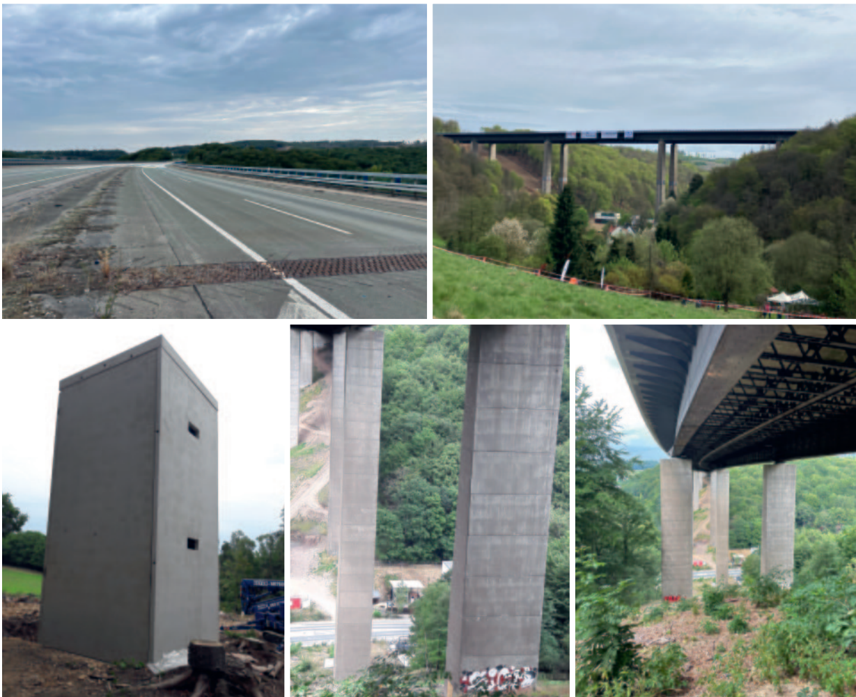
Abb. 49: Ansicht von Norden/Fernsicht/Fledermausersatzturm/Hanglage Blickrichtung Widerlager/Unterhalb der Talbrücke (Fotos: FBA)
