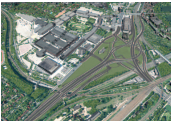
Abb. 38: Übersicht über das Autobahndreieck Funkturm (A 100/A 115) in Berlin (Quelle: DEGES)
