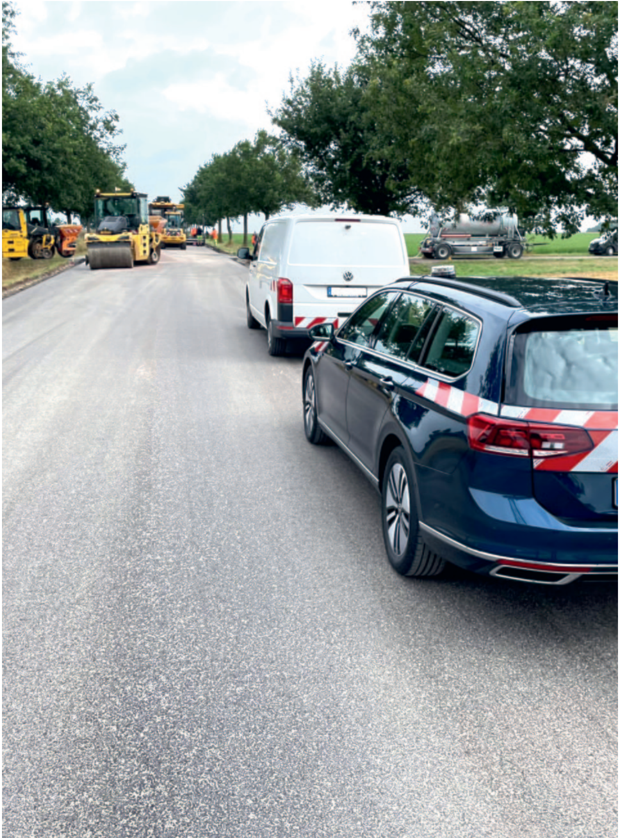
Abb. 13: Beginn einer Baumaßnahme in Sachsen-Anhalt, bei der die Asphaltdecke in kompakter Asphaltbauweise hergestellt werden soll. (Foto: FBA)
