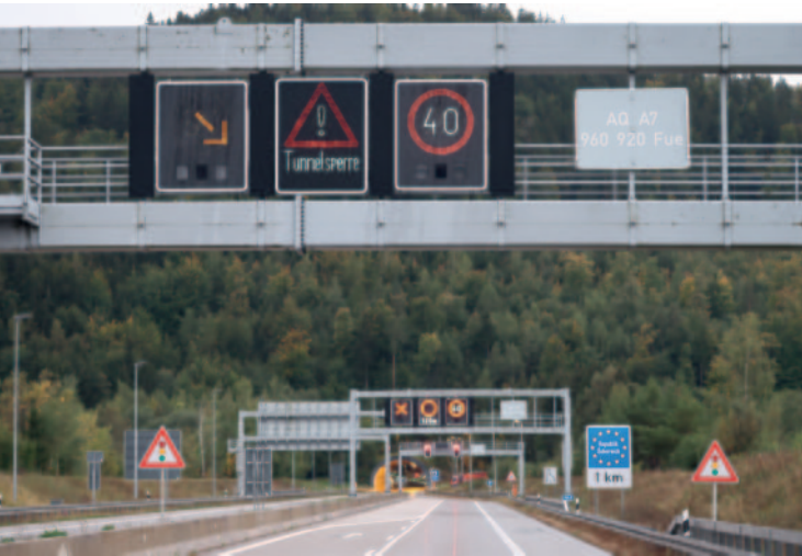
Abb. 7: Tunnelsperre (Foto: FBA)
